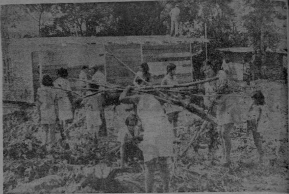
Los habitantes de “Aguantafilo” cortan el cafetal de cinco manzanas y media en donde se construirán las cómodas viviendas en donde residirán próximamente. Al fondo de esta fotografía se aprecia una casa casi terminada. — (Foto Córdoba).
